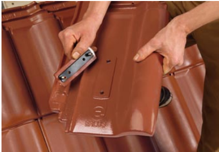
3. Die 2-teilige Solarhalterung trennen und das untere Teil auf die Alu-Grundplatte befestigen.
