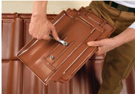
4. Schrauben an der Unterseite anziehen.
