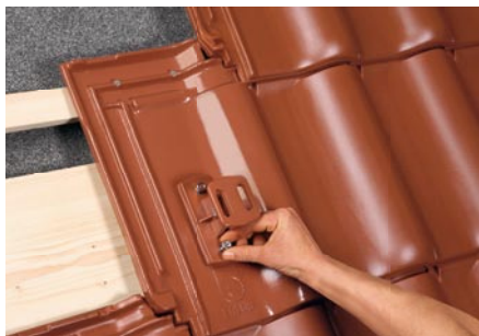
8. Obere Solarhalterung aufbringen.
