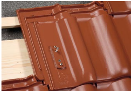
6. Lockere Befestigung mit Schrauben (6 x 80 mm). Der Karat lässt auf Grund der großen Verfalzung nur eine Befestigung zu.
