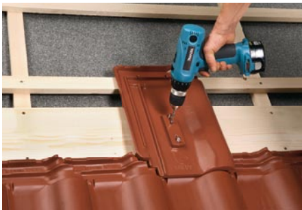
5. Bohren des oberen Loches durch die Alu-Grundplatte (Bohrer 6 mm) zur Befestigung in die Bohle.
