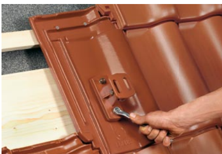
9. Mit Schraubenschlüssel (13 mm) aufschrauben.
